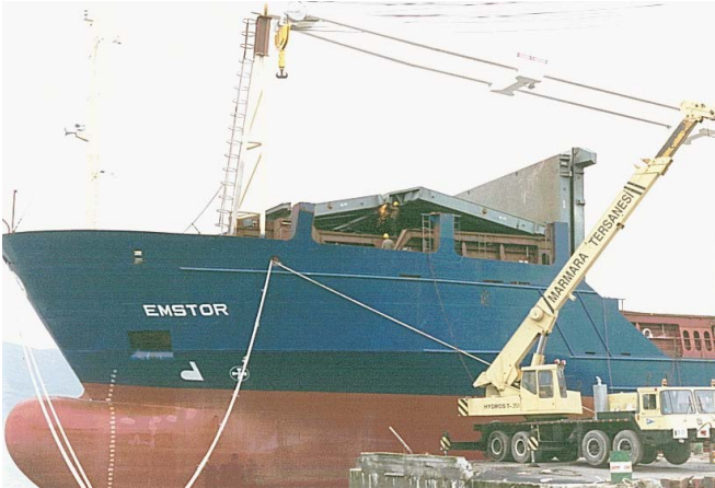
Emstor gemisinin kapakları monte ediliyor, Marmara Tersanesi
