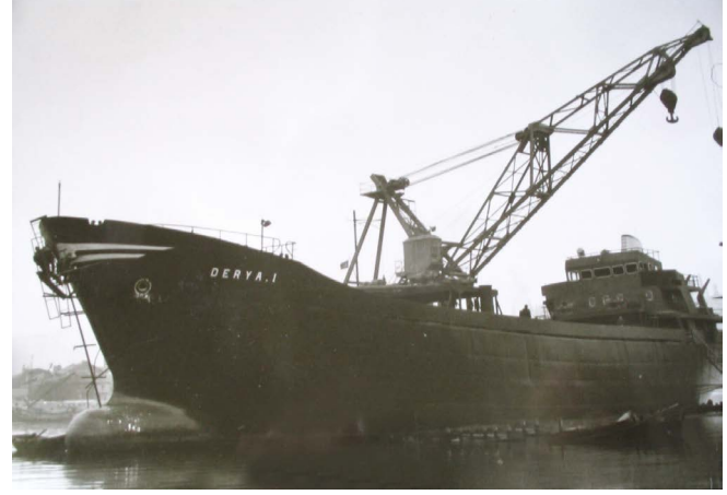
Derya I gemisinin üst bina montajı yapılırken, Sütluçe 1974
